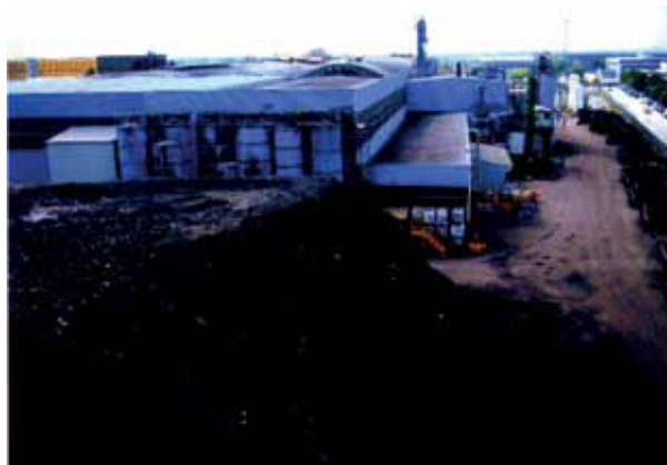
AFC S.p.A. Cumulo di "scoria vecchia" visto da nord est
